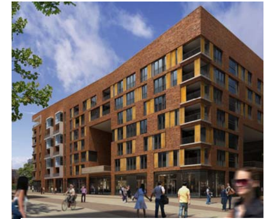
SPV7/8, NPS Architekten: Massive Fassadenstützen gliedern die Schaufensterfront des Sockels
